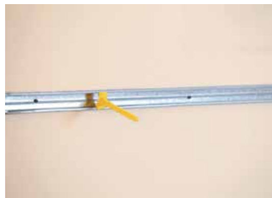
Étape pose des tiges d' Appui Optima 2 sur la fourrure horizontale murale Fourrure Optima
