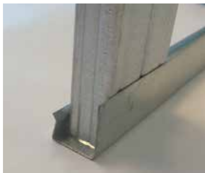
Détail liaison Lisse Clip Optima avec fourrure verticale Fourrure Optima 240
