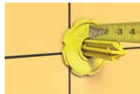
Première étape de l'étanchéité à l'air au niveau de chaque appui Optima 2 : mise en place de la rondelle de la pastille Optima 2
