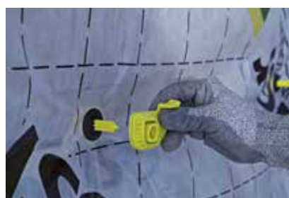
La clé d'appui Optima 2 peut être posée de façon provisoire avant la pose de l'ossature verticale
