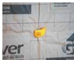
Pose de la clé d' Appui Optima 2 en position ouverte
