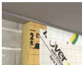
Rabat et liaison de la bande de membrane Vario® Xtra avec Vario® Xtra Band avec double face intégré en partie haute de mur
