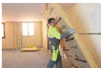
Mise en œuvre de l'isolant GR32 et embrochage sur les tiges d' Appuis Optima 2
