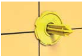
Première étape de l'étanchéité à l'air au niveau de chaque appui Optima 2 : mise en place de la rondelle de la pastille Optima 2
