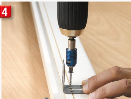
4 Fixation par vissage des 7 équerres sur le dormant :
