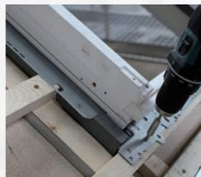
**4.** Fixer un liteau en partie haute et partie basse\* du logement permettant de visser les équerres de la fenêtre.
