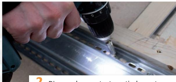
**2.** Disposer les montants verticalement sous les liteaux de part et d'autre du logement puis visser les montants aux traverses à raison de 2 vis à chaque angle.
