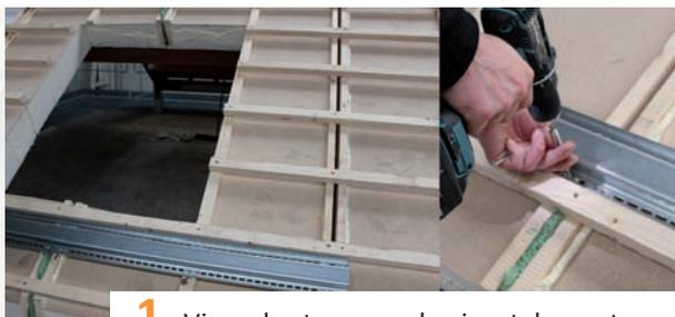
**1.** Visser les traverses horizontalement derrière le dernier liteau non découpé en bas et en haut de l'emplacement de la fenêtre.
