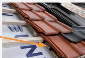
**Deux traverses oméga en acier galvanisé** permettant la reprise mécanique des panneaux découpés sur les chevrons voisins.
