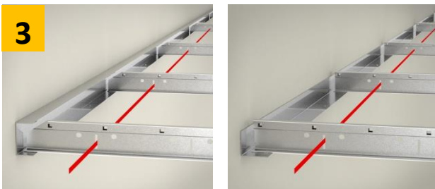
3. MISE EN OEUVRE DES PORTEURS
