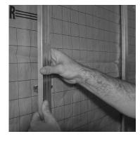
3. Clipser la fourrure sur le cavascope en engageant une aile dans la fente verticale et pivoter jusqu'au CLIC. Pour un alignement parfait, ajuster le réglage à l'aide de la vis violon.
