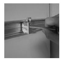
Fixer les fourrures à 1,35 m du sol puis clipser les cavascopes tous les 60 cm max Visser la tige filetée dans le trou taraudé prévu à cet effet.
