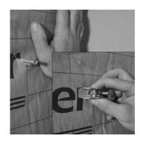
Perforer l'isolant et fixer le second cavascope à l'aide du trou lisse et de la vis violon.
