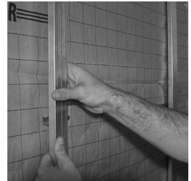
3. Clipser la fourrure sur le cavascope en engageant une aile dans la fente verticale et pivoter jusqu'au CLIC. Pour un alignement parfait, ajuster le réglage à l'aide de la vis violon.
