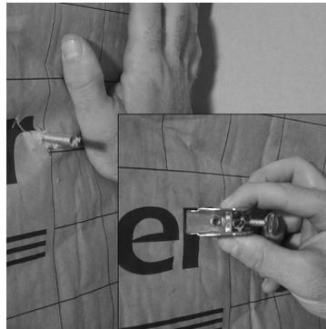
2. Perforer l'isolant et fixer le second cavascope à l'aide du trou lisse et de la vis violon.
