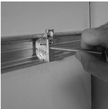
1. Fixer les fourrures à 1,35 m du sol puis clipser les cavascope tous les 60 cm max Visser la tige filetée dans le trou taraudé prévu à cet effet.
