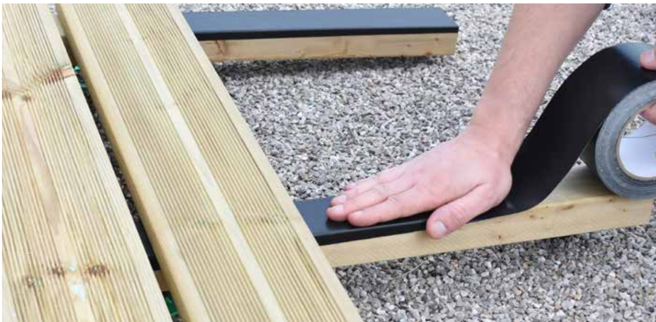
Étanchéité des lambourdes bois sous terrasse
